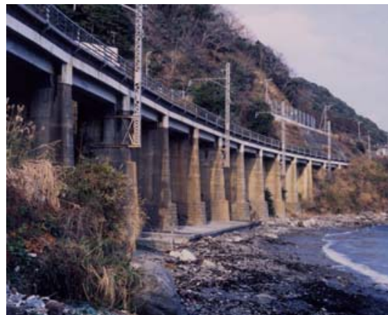
(a) 山生橋梁 2)
