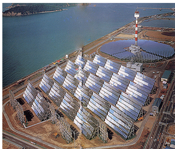
写真1 仁尾町太陽熱実証実験設備
