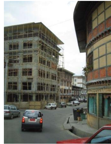
<ティンパーの建築現場(足場は竹)>
