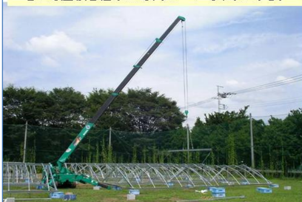
地上で屋根を組み立て、クレーンで吊り上げる。
